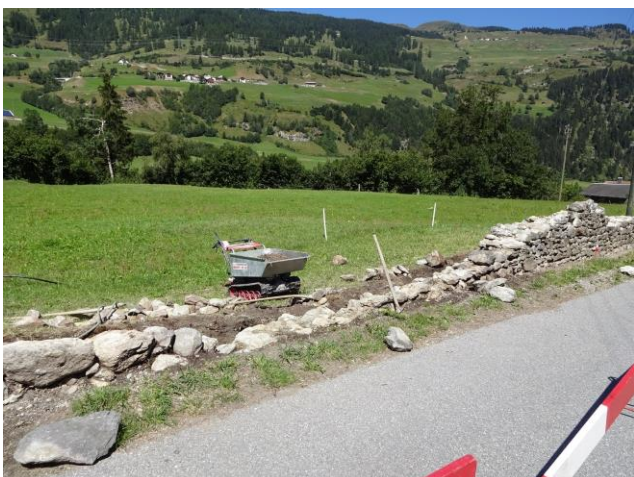
Jul 2015 Freilegung des westlichen Mauerfusses durch den ADG, Schnitt zum Fundamentbereich
